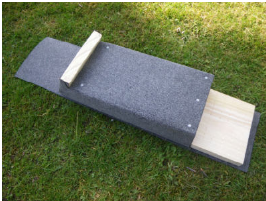
Foto 10: Kasten auf die Teerpappe legen und vorne auf der Dachkante festnageln
