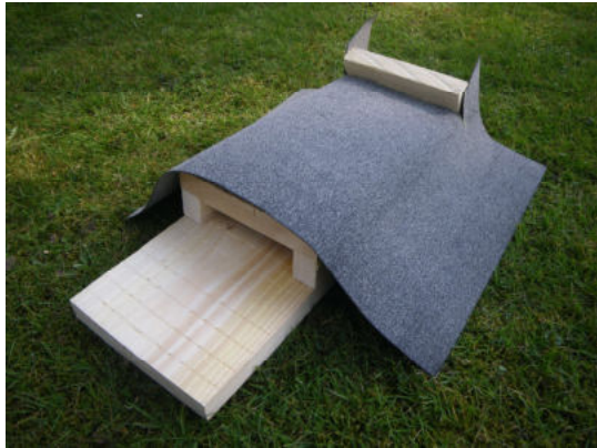
Foto 8: Front mit Teerpappe bedecken, bis auf die Rückseite umschlagen und mit Pappnägeln befestigen
